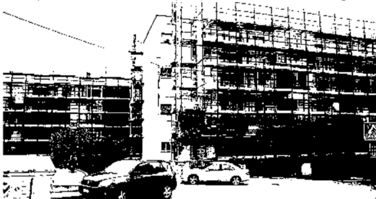
A Piazzale Moroni sono numerosi i palazzi interessati dai lavori per eliminare l'amianto
